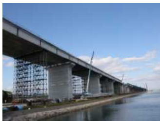
※四国横断自動車道（沖洲高架橋工事）
