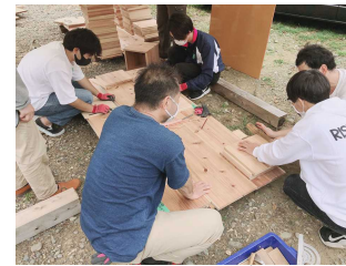
(空き家改築作業)
