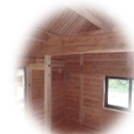
板倉構法 仮設住宅
