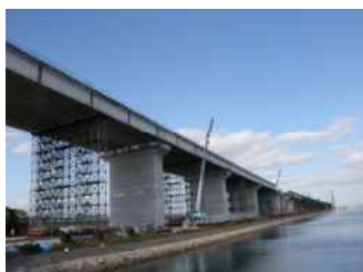
※四国横断自動車道（沖洲高架橋工事）
