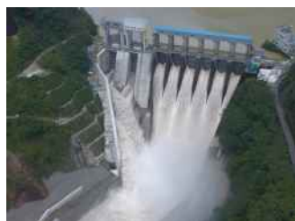
※長安ロダム改造事業（放流ゲート増設）
