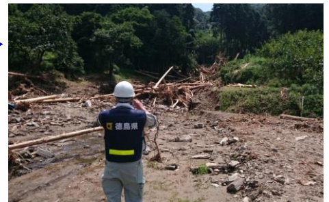
被災状況調査の様子
