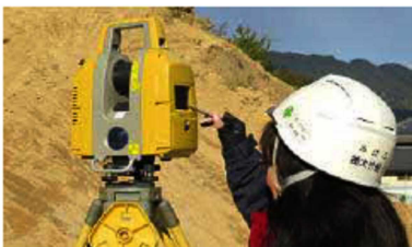
3次元設計データによる作業土工（床掘）を進めるMGバックホウとワンマン3次元測量
