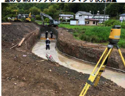
3次元設計データによる作業土工（床掘）を進めるMGバックホウとワンマン3次元測量
