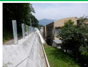
<つるぎ町真光 急傾斜地崩壊対策工事>
