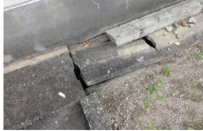
コンクリートの破損
