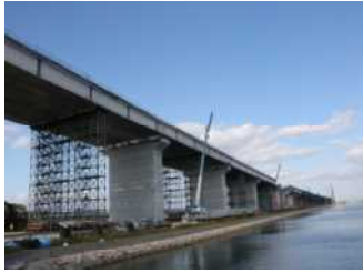
※四国横断自動車道（沖洲高架橋工事）
