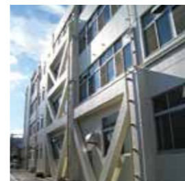
徳島中央高等学校 校舎耐震補強
