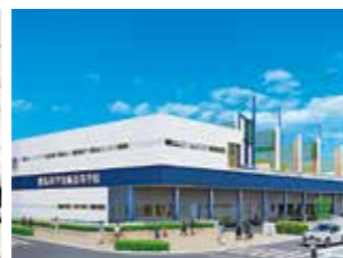
徳島科学技術高校 スポーツ施設新築工事
