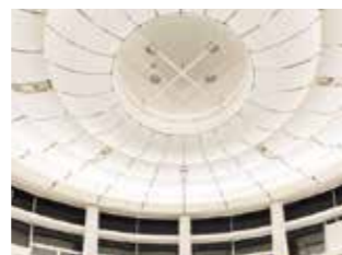
あすむらんど子ども科学館 天井改修工事
