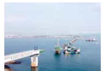
建設中の四国横断自動車道
