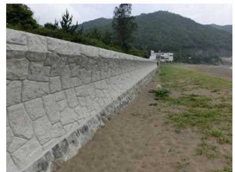
大浜海岸防潮堤
