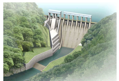
長安口ダム改造
