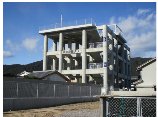
津波避難タワー
