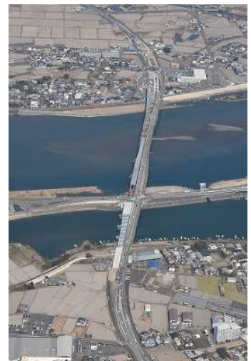
那賀川大橋（四国地方整備局提供）
