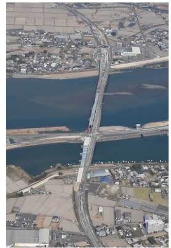
那賀川大橋（四国地方整備局提供）
