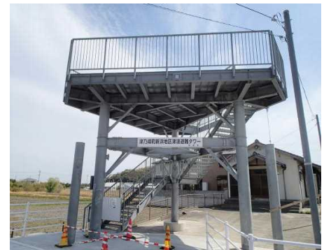
津波避難タワー
