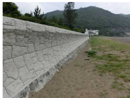
大浜海岸防潮堤
