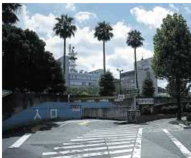
藍場町地下駐車場
