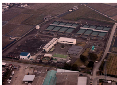
吉野川北岸工業用水道
