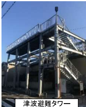
津波避難タワー
