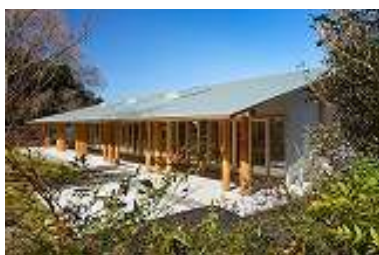
図1 林業人材育成棟外観
