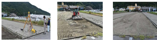
レーザー発光器 レーザーレベラーによる施工 施工完了
