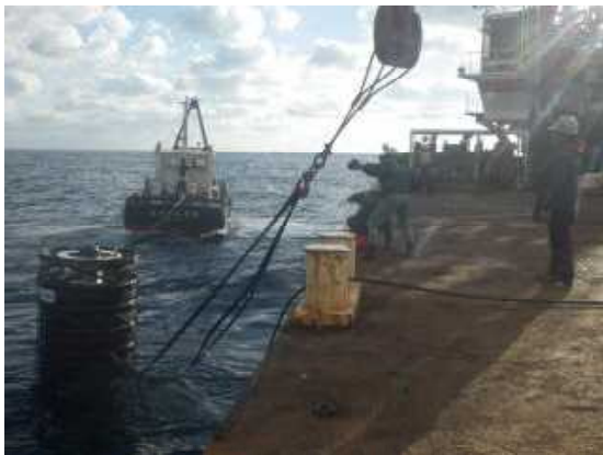
中層型浮魚礁*の設置
