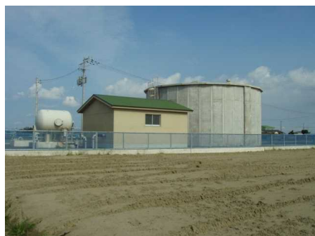
畑地かんがい施設（揚水機場）
