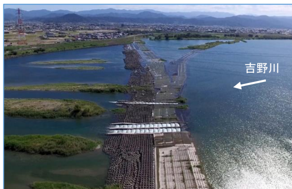
写真2-21 第十堰(石井町・上板町)
