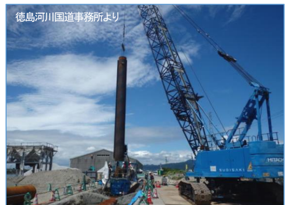
写真2-35 液状化対策工事
