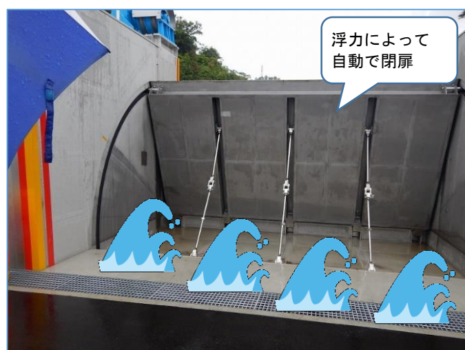
施策2-2 陸閘閉鎖の自動化
