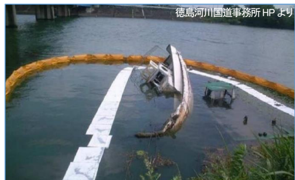
施策2-4 シルトフェンスによる油等拡散防止 徳島河川国道事務所 HP より
