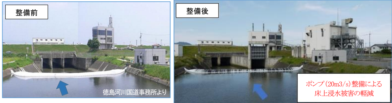
写真2-27 角ノ瀬排水機場の整備前後(徳島市)
