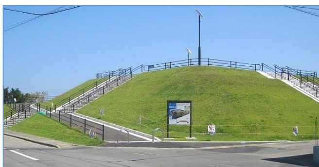
施策3-2 除去した土砂を有効活用した津波避難施設(小松島市)
