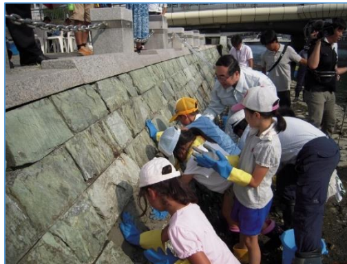
施策4-2 県民との協働による護岸の修理(新町川)
