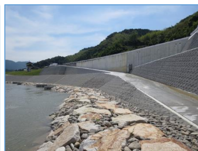
施策5-3 消防用水取水に活用できる坂路
