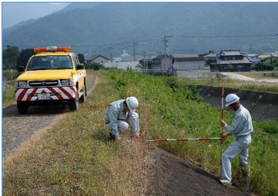
施策4-1 堤防の点検状況
