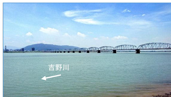
写真2-20 眉山と吉野川橋
