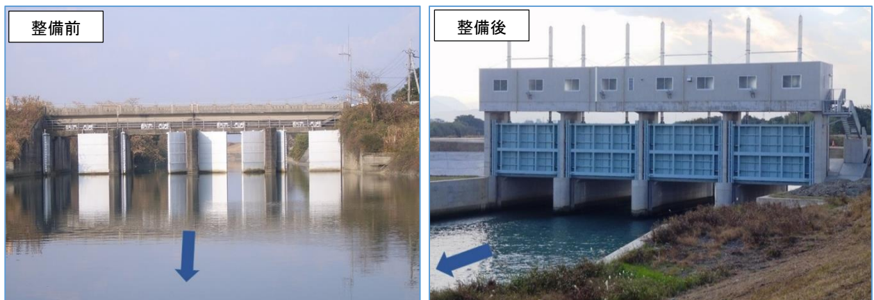
写真2-28 飯尾川第二樋門の改築前後(徳島市)
