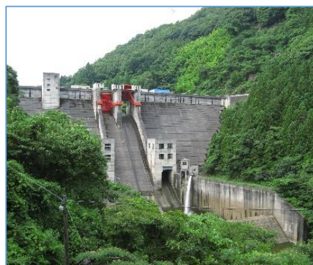
写真2-23 正木ダム(上勝町)
