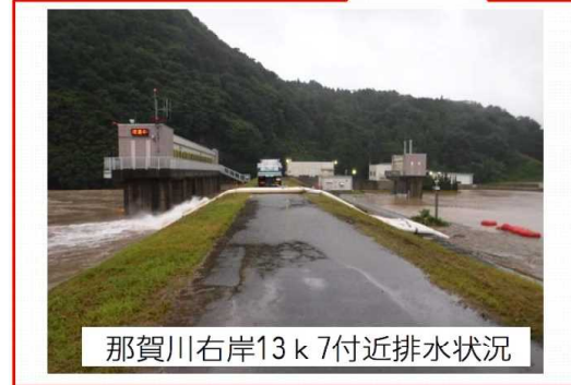
那賀川右岸13k7付近排水状況
