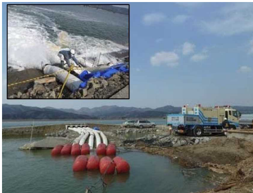
排水ポンプ車(排水能力毎分150m 3 東北最大級)による作業
