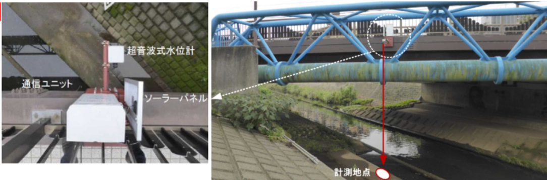
洪水時の水位観測に特化した危機管理型水位計の設置
