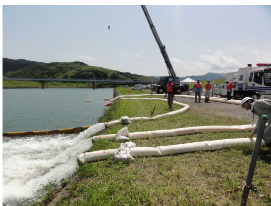
【施策1-3】 排水ポンプ車操作による内水排除
