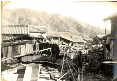
地震により倒壊した家屋
