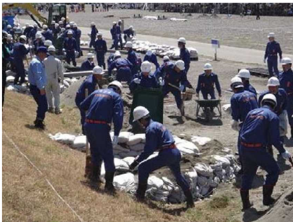
漏水対策「月輪工」
