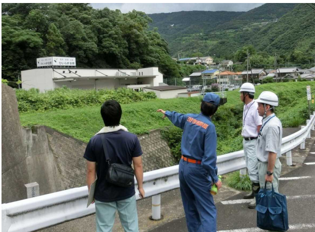
水防団や河川管理者合同で実施する重要水防箇所の点検
