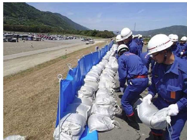
洗掘対策「積土のう工」
