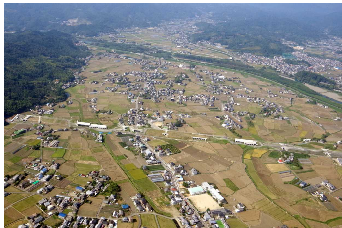
四国横断自動車道(小松島市)
