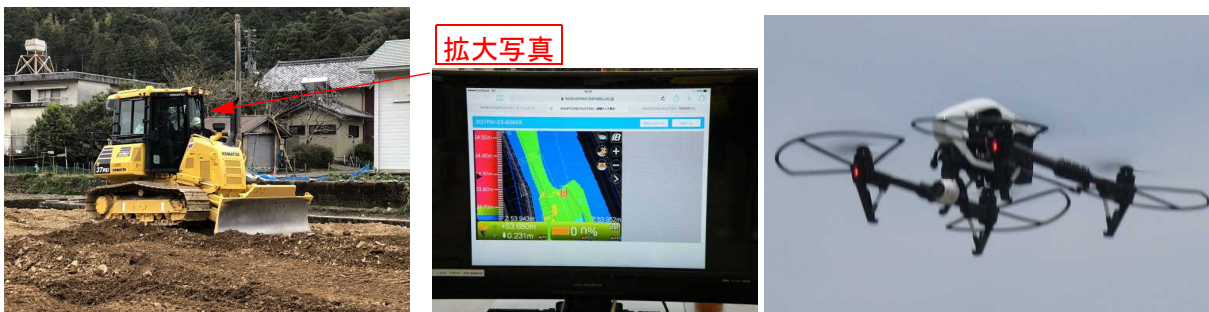
ブルドーザーの遠隔操作による土砂の敷均し作業
