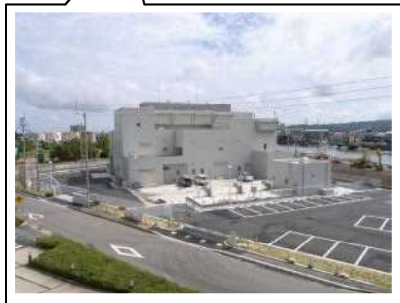
雨水ポンプ場
