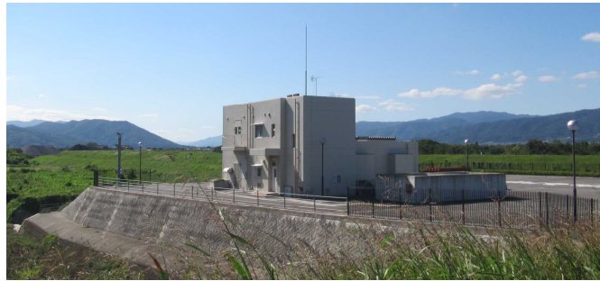
ほたる川排水機場
