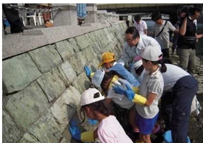
【施策4-2】 県民との協働による護岸の修理
