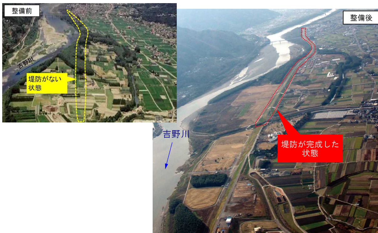
写真 5 - 3 堤防整備状況（三好市三野町）
