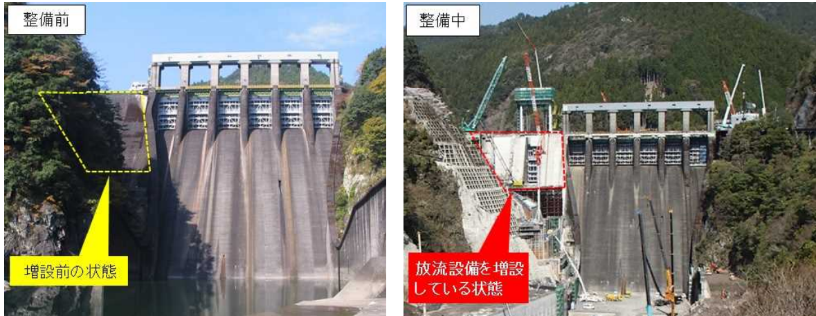
写真 5 - 1 0 長安口ダム改造の状況（那賀郡那賀町）
