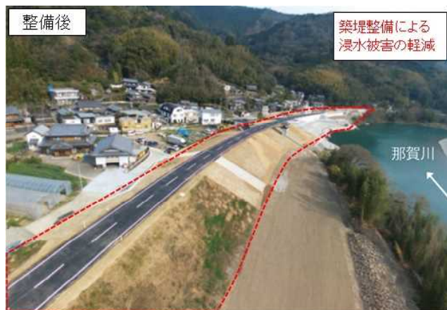
写真 5 - 9 堤防整備状況
