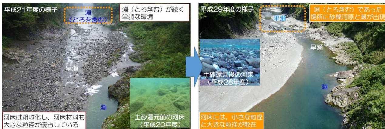
写真 5-11 土砂還元による河川環境の改善効果
