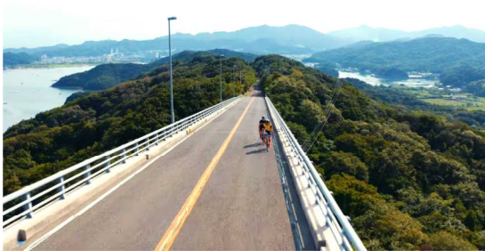
鳴門スカイライン (鳴門市)
