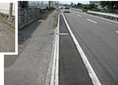
路側の改善（側溝の改修） （出典：愛媛県）
