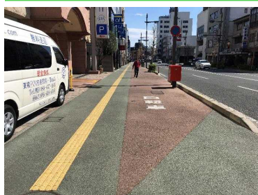
国道438号 (徳島市大工町)
