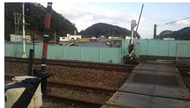
遮断機(現海部駅)
