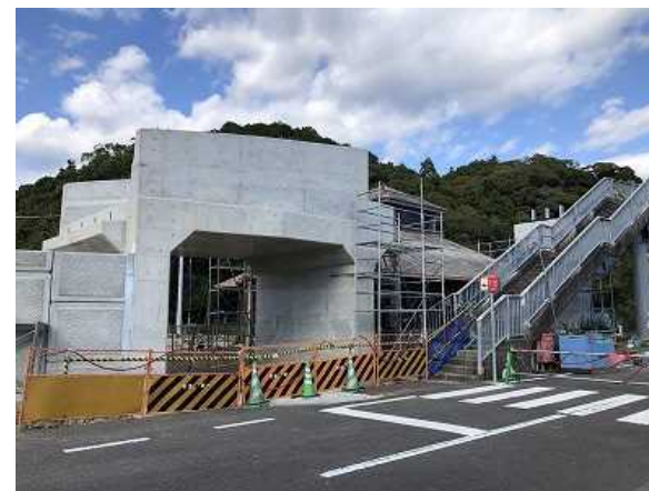
甲浦駅工事の様子(R1.12.4撮影)
