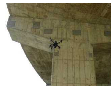
ドローンによる点検
