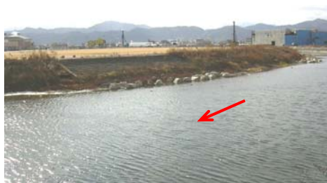
飯尾川公園いしいドーム付近の親水護岸
