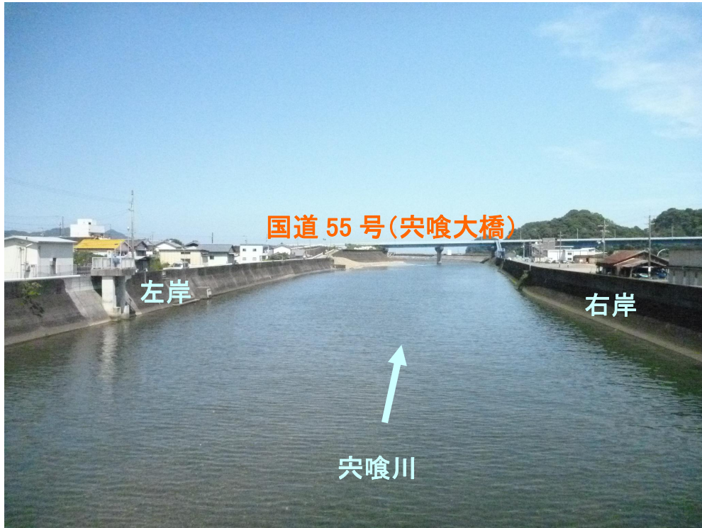
液状化により沈下の恐れのある堤防
