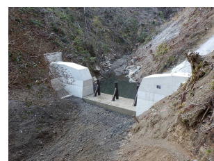
山地流木捕捉式 治山ダム
