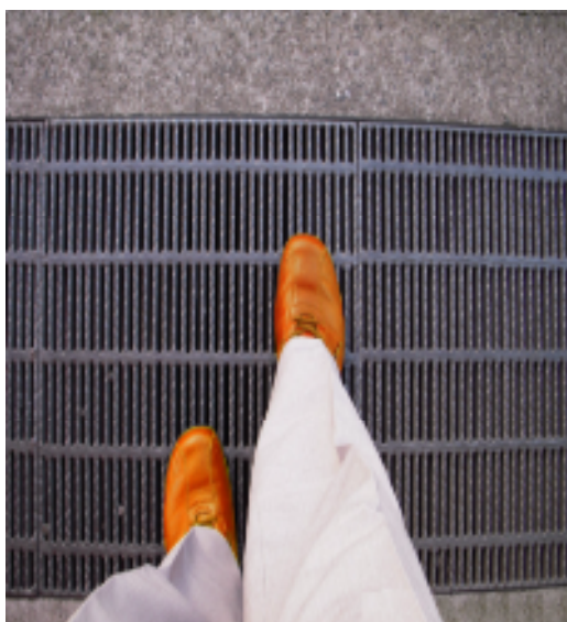
細目 ノンスリップ （車輪や杖がはまり込まず滑りにくい）
