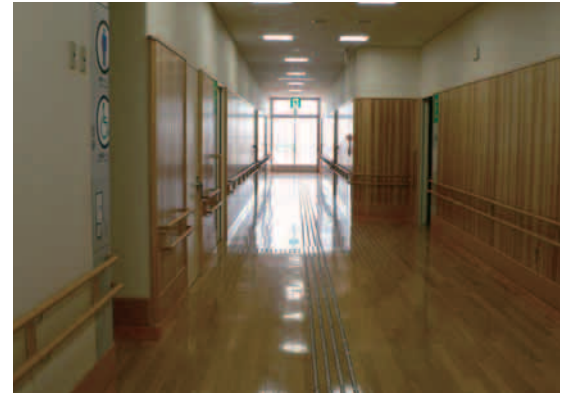
連続して設けられた手すりの例 (障害者交流プラザ)
