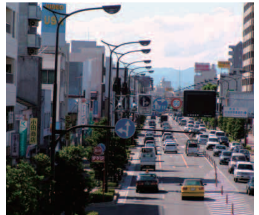
周辺との景観に配慮した照明計画の例 (国道192号)
