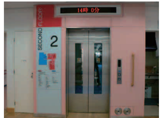
ガラス窓がついたエレベーター (障害者交流プラザ)
