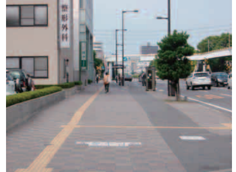
歩行者と自転車をカラー舗装等で区分する例(徳島鴨島線)
