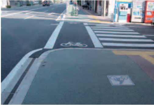
歩行動線上に重ならないように排水施設を 設置する例(宮倉徳島線)
