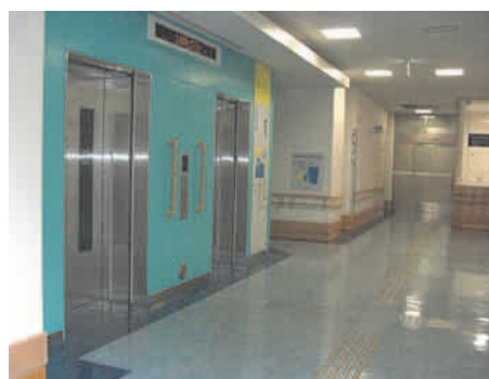
建物内の視覚障害者誘導用ブロック (障害者交流プラザ)
