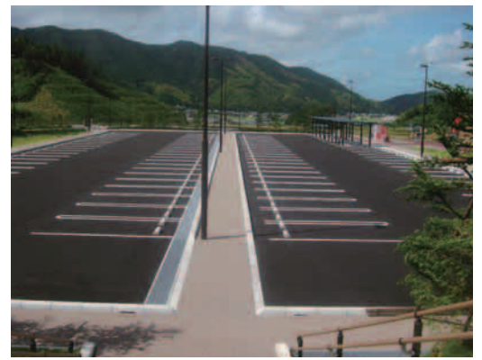
車道と分離された安全な通路 (南部健康運動公園)
