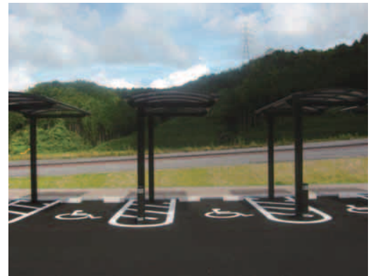
屋根の設けられた車いす使用者用駐車場 (南部健康運動公園)
