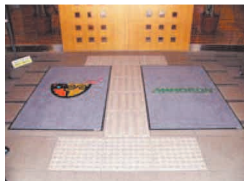
誘導用ブロックを避けて水拭きマットを敷いている例
