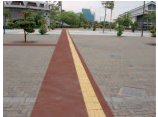
誘導用ブロック、薄層舗装 (鳴門・大塚スポーツパーク)
