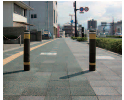
車止めの例(徳島鴨島線)
