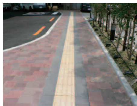
背景色との明度差を確保するため、周りを縁取りした視覚障害者誘導用ブロック
