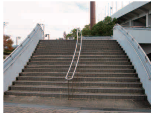
中間に手すりを設けた例 (ポカリスエットスタジアム)
