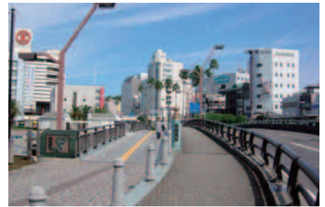
歩行者と自転車を構造物等で区分する例(国道438号)
