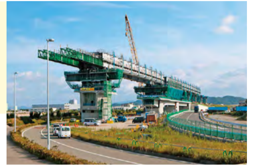
四国横断自動車道(吉野川大橋工事)
