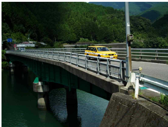
日常パトロールの状況
