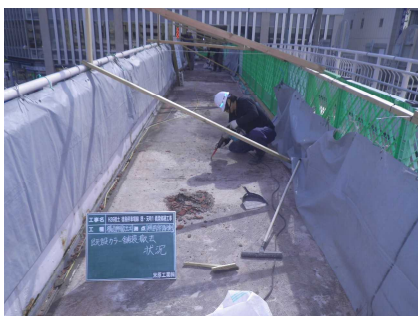
① 既設カラー舗装撤去
