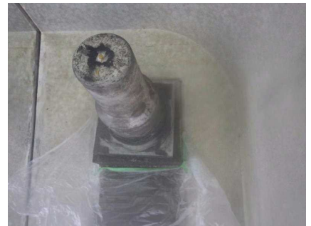
⑥ 交換作業完了
