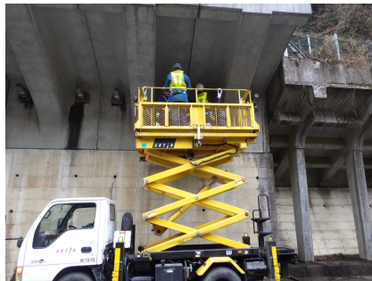
② キャップ取外し作業状況
