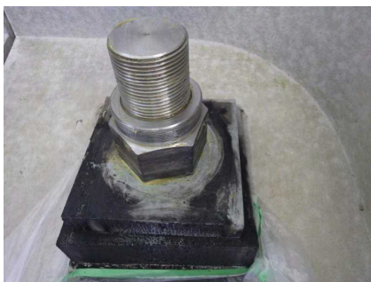
④ アンカーヘッド清掃
