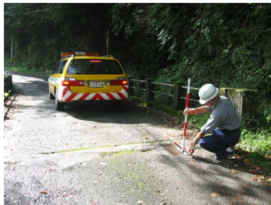
日常パトロールの状況
