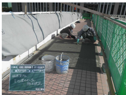
② 磁器質タイル施工
