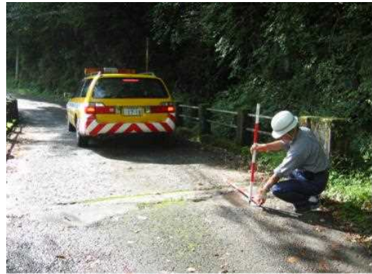
日常パトロールの状況
