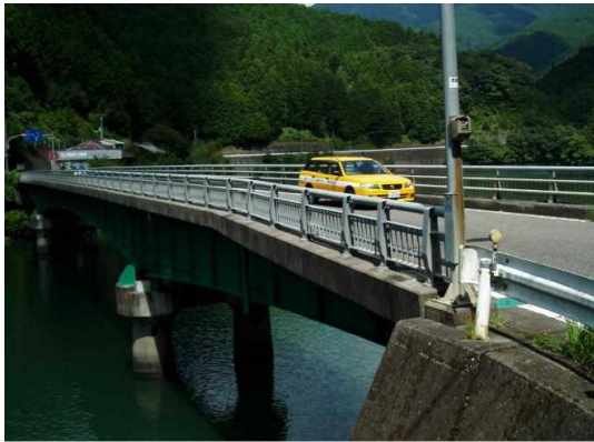
日常パトロールの状況
