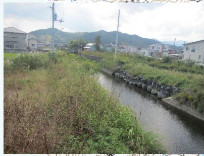
平常時 (未改修区間)
