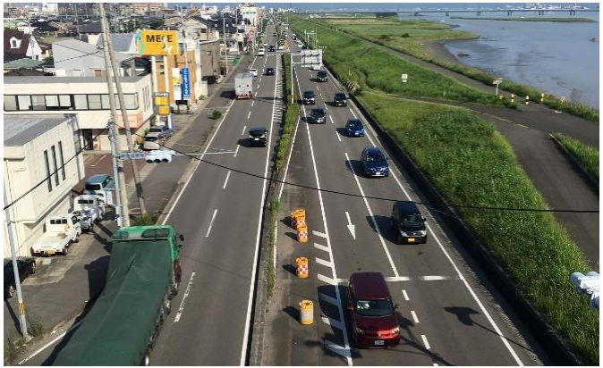
H15供用区間
