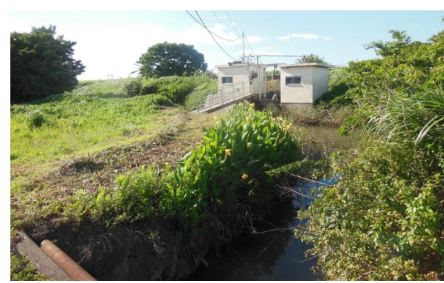
金沢排水機場
