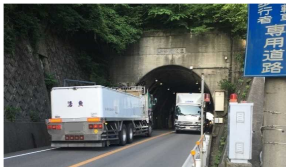
小鳴門トンネル
