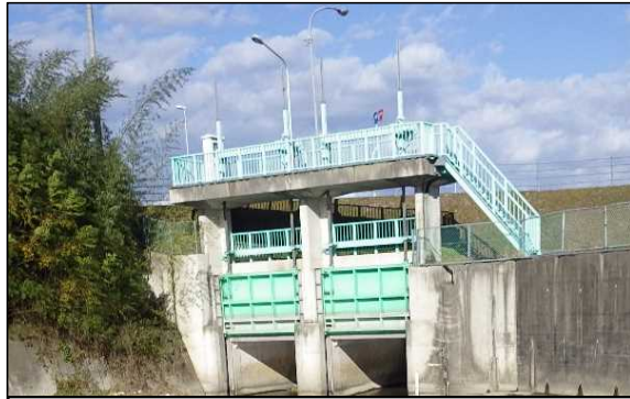
六条暗渠樋門 (起点)
