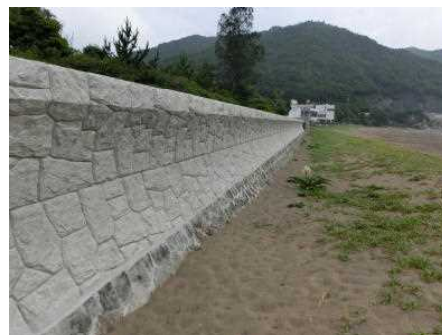
大浜海岸防潮堤
