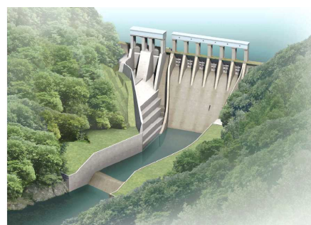
長安口ダム改造
