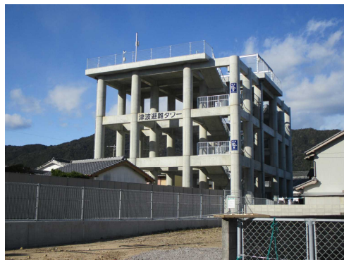
津波避難タワー
