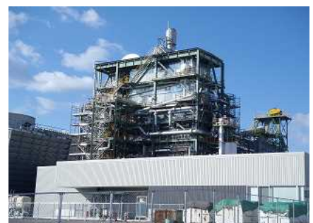
バイオマス発電所 (クラボウ)
