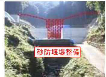
砂防堰堤整備 岩・土砂流出など二次災害予防 (東みよし町・赤ハダ谷)
