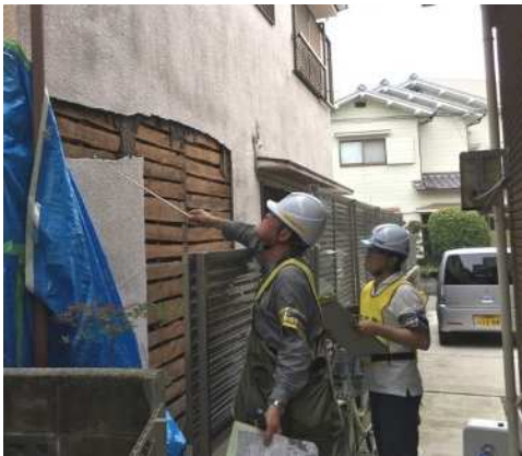
大阪府北部地震 連携協定による「徳島県建築士会」危険度判定
