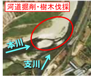
河道掘削・樹木伐採 河川の流下能力向上 (勝浦町・勝浦川)
