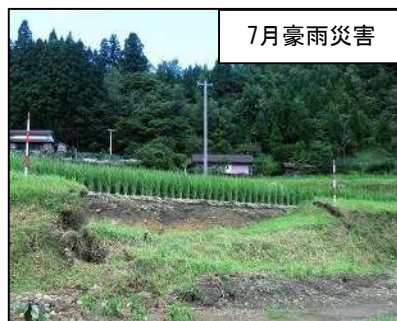
農地の被災（畦畔の崩壊）
