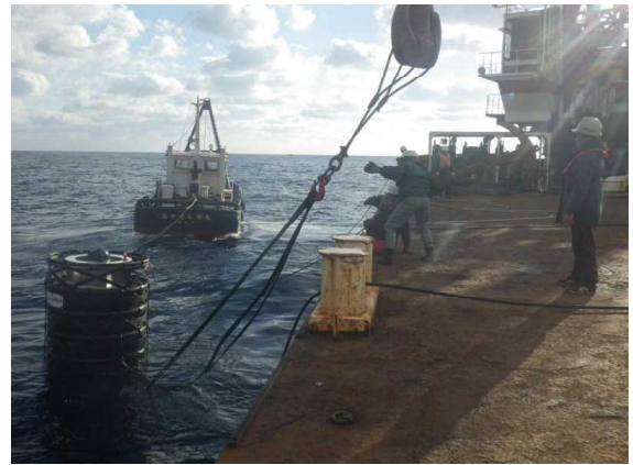
中層型浮魚礁の設置
