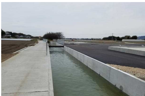
幹線水路（那賀川地区）
