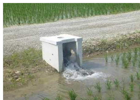
末端給水栓の整備
