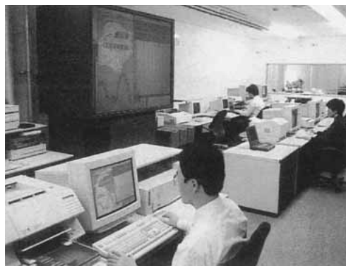
テレメータ中央監視局
