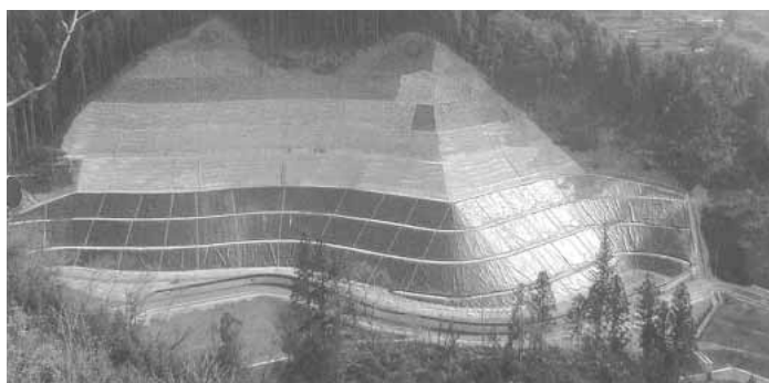
最終処分場（みよし広域連合清掃センター・池田町）
