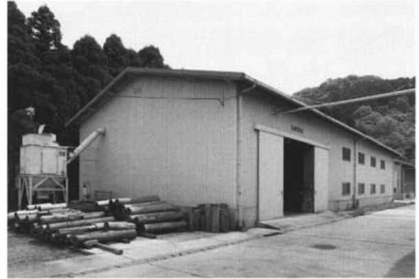
実大強度試験棟の全景
