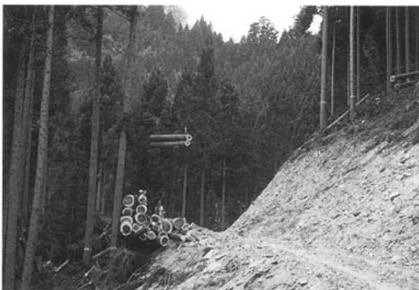
単線循環式架線による間伐生産状況
