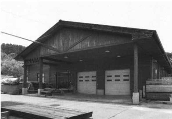
新技術開発試験棟の全景
