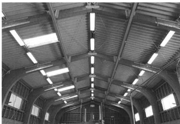
実大強度試験棟の内部
