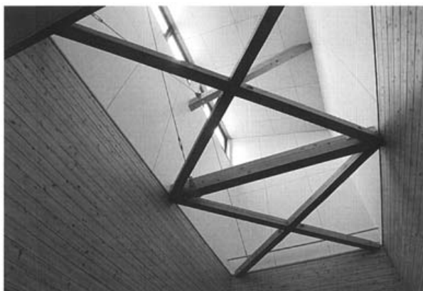
新技術開発試験棟の内部
