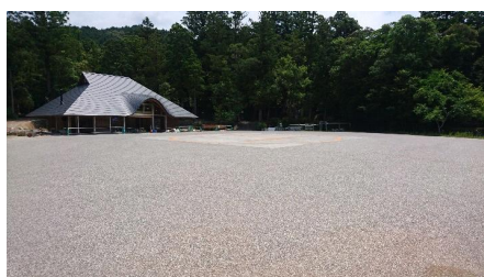
山間部に設置する防災拠点の整備
