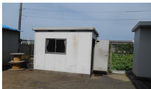
既存建物外に喫煙室
