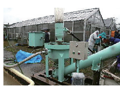
図4 洗浄試験の様子
