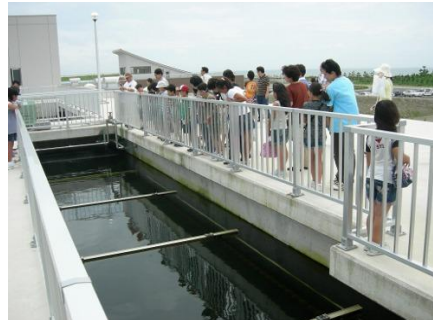
さいしゅう 最終ちんでん池とよばれる池 11～12ページの処理3(汚泥を しずめる処理)をしている池です。
