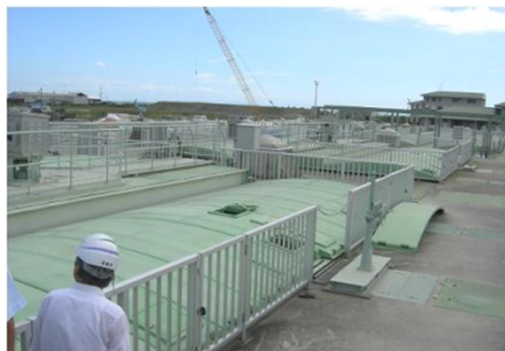
はんのうそう 反応槽とよばれる池 池はフタでおおわれていますが、 11～12ページの処理2(び生物 での処理)をしている池です。
