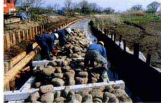
不要となった蛇籠の中詰石を沈床に再使用 (長良川・岐阜県)
