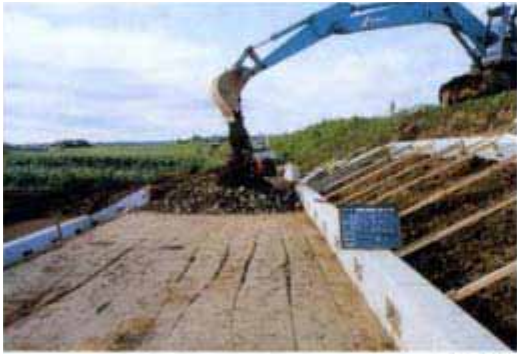
コンクリート塊を護岸裏込め材として再利用 (厚真川・北海道)
