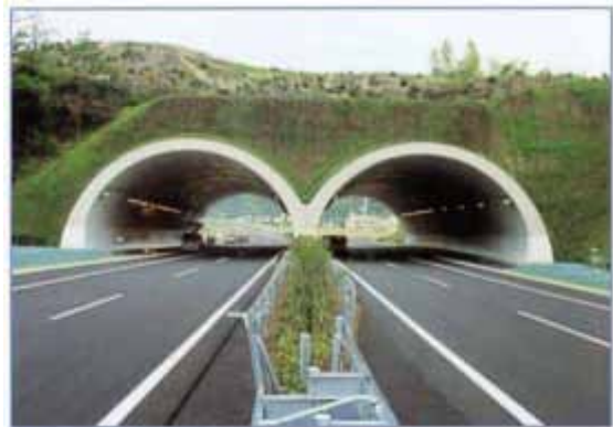
大代トンネル
