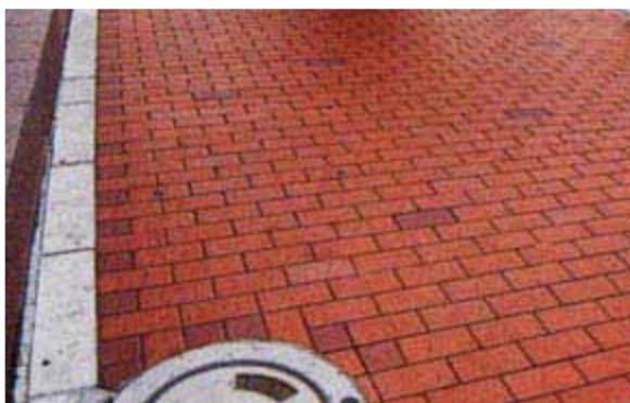
舗装材として利用されているメトロレンガ。
