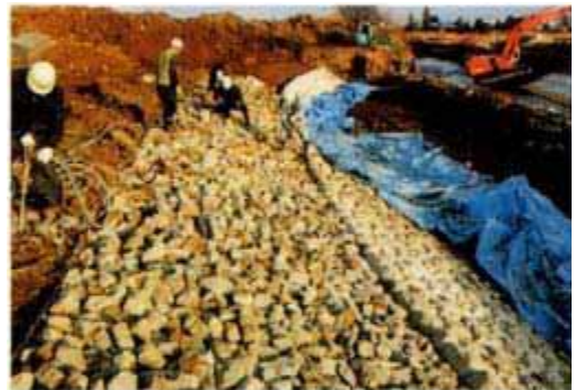
コンクリート塊をカゴマットに再利用 (由仁川・北海道)
