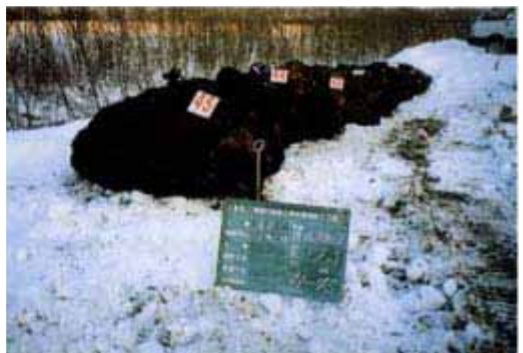
不要になったブロックをネットに入れて護床工として再利用 (剣淵川・北海道)
