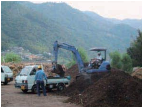
希望者へ無料配布している。軽トラックで来場した人には重機で積み込みを行っている。
