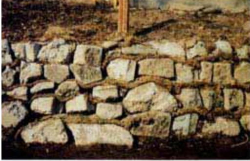
コンクリート塊を空積み護岸に再利用 (精進川・北海道)
