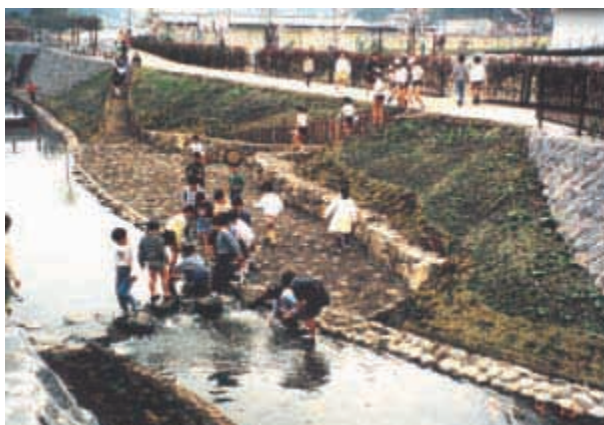
改修後の小学校と川の様子
