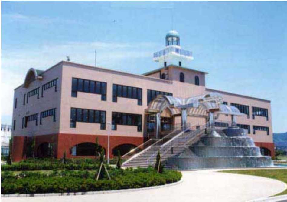
西浄化センターの管理棟。平成10年3月より運転を開始している。
