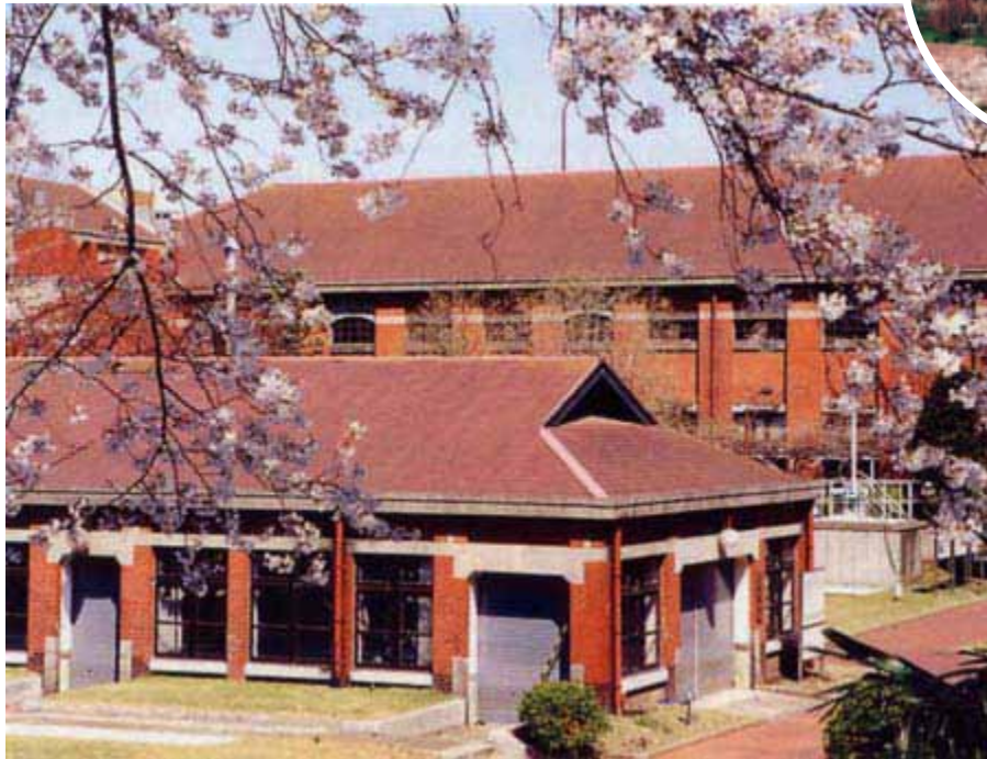
旧主ポンプ室
