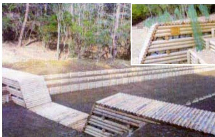
床固工、流路工②
