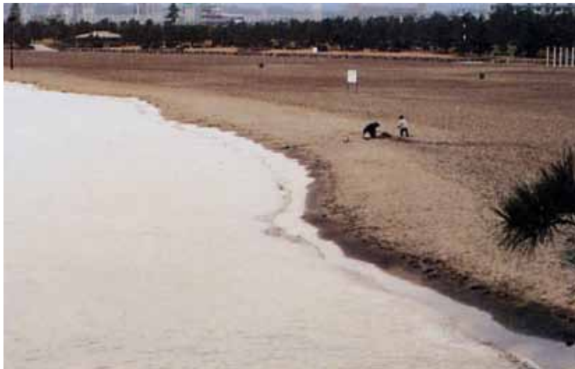
延長約1kmの海岸に広い砂浜を造成。砂浜用の砂は山砂を利用し、5年間海底に仮置きし、アサリ生息の実証試験を繰り返した後に、使用している。
