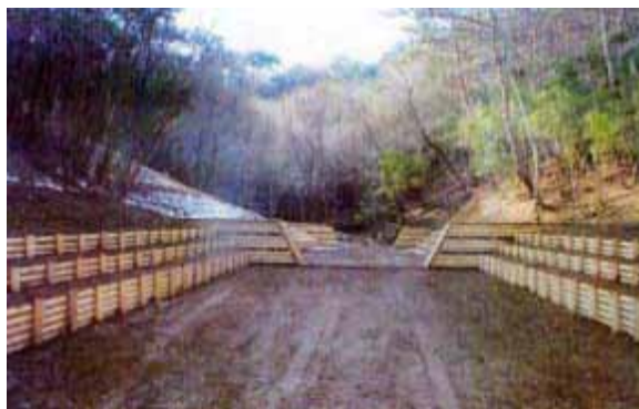
床固工、流路工①
