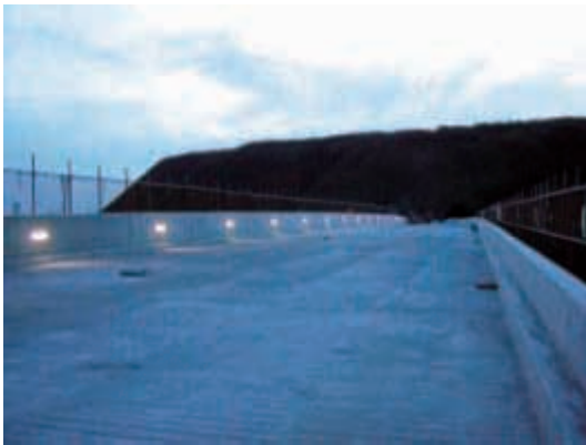
海浜部も盛土でなく橋梁形式とし、産卵区域を極力残した。工事中も、桁の設置において、建設機械を砂浜におろす回数を極力減らした。
