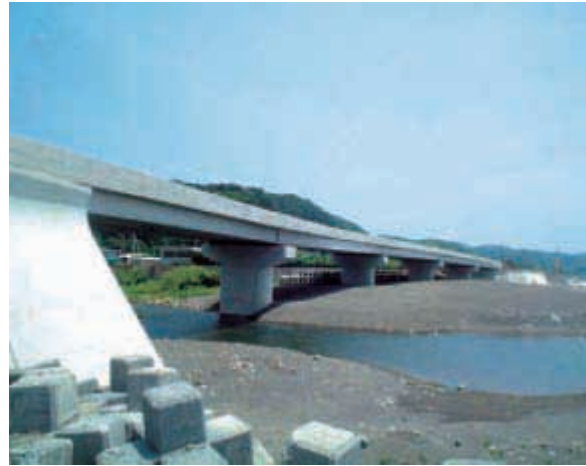
海浜部も盛土でなく橋梁形式とし、産卵区域を極力残した。工事中も、桁の設置において、建設機械を砂浜におろす回数を極力減らした。
