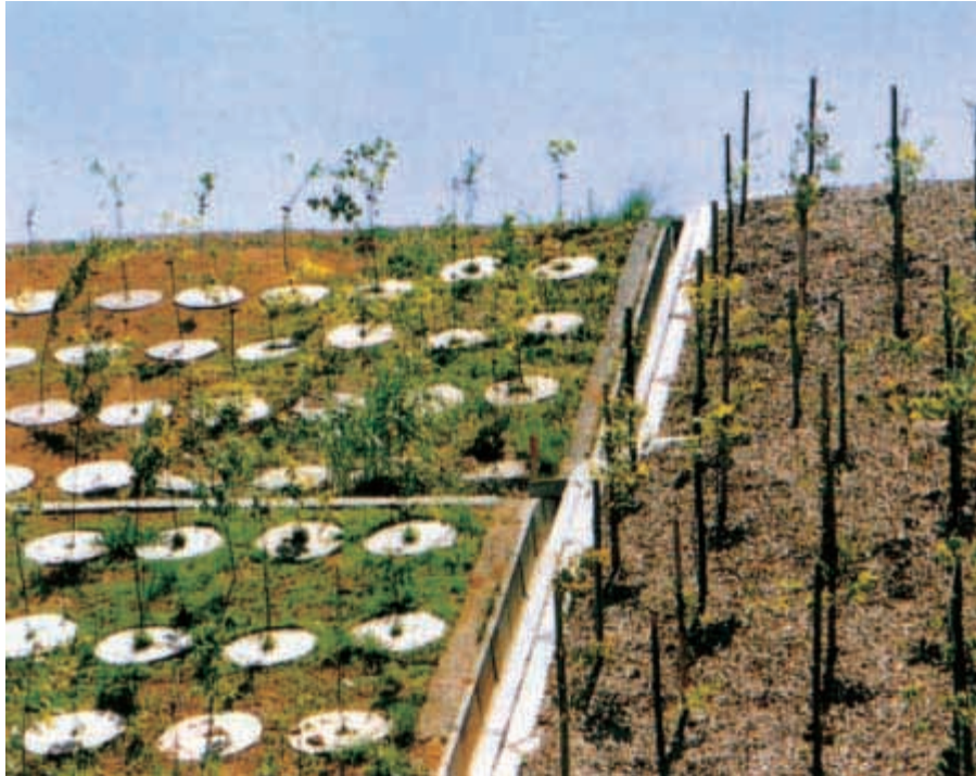
マルチングボードや木チップで法面を被覆し、郷土種を利用して復元緑化を実施。
