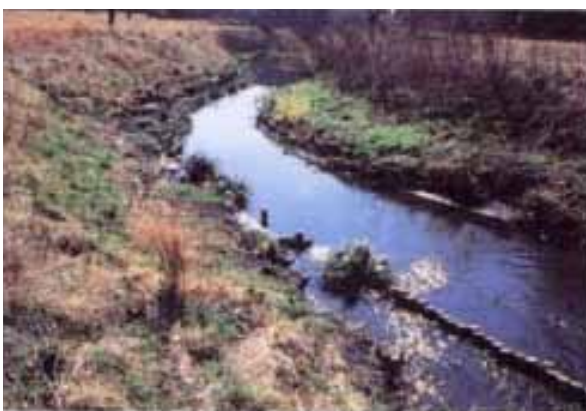
水辺構造が多様化 出水により、植生保護ロールの裏側が洗掘され、水辺構造が多様化した。
