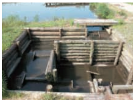
遡上施設の様子
