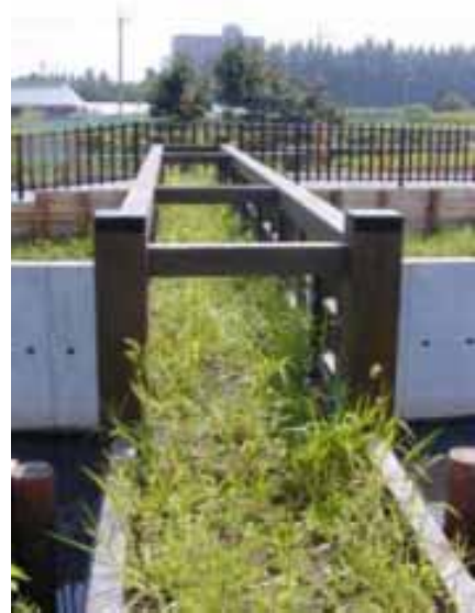
エコブリッジ（後谷ツ排水路）
