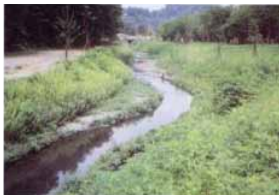
完成後 植生と土による護岸に置き換え緩やかな蛇行と瀬・淵を形成した。
