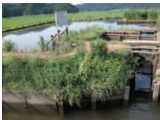
遡上施設入口
