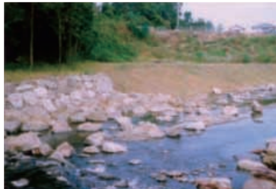
平成8年11月 自然素材を用いているため、自然的景観となっており、緩傾斜としたことで、親水性が向上した。水際には自然石を配置し、淵の形成を図る。
